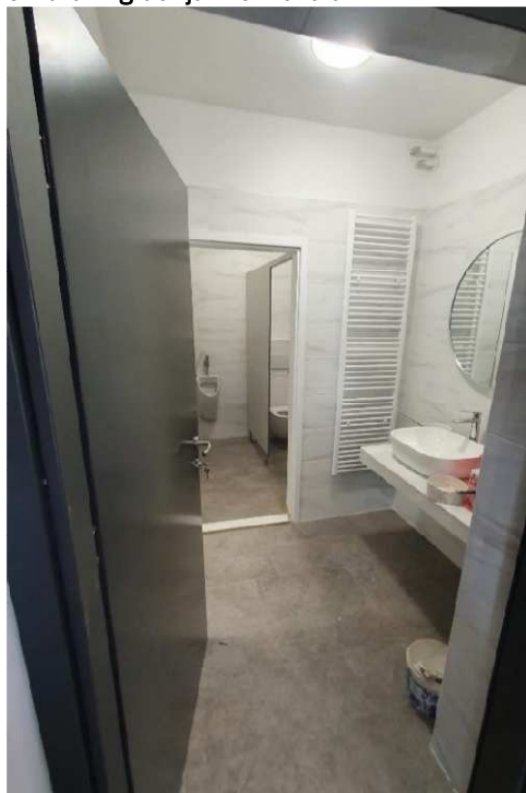
Slika 6: Izgradnja WC v dvorani Krim
