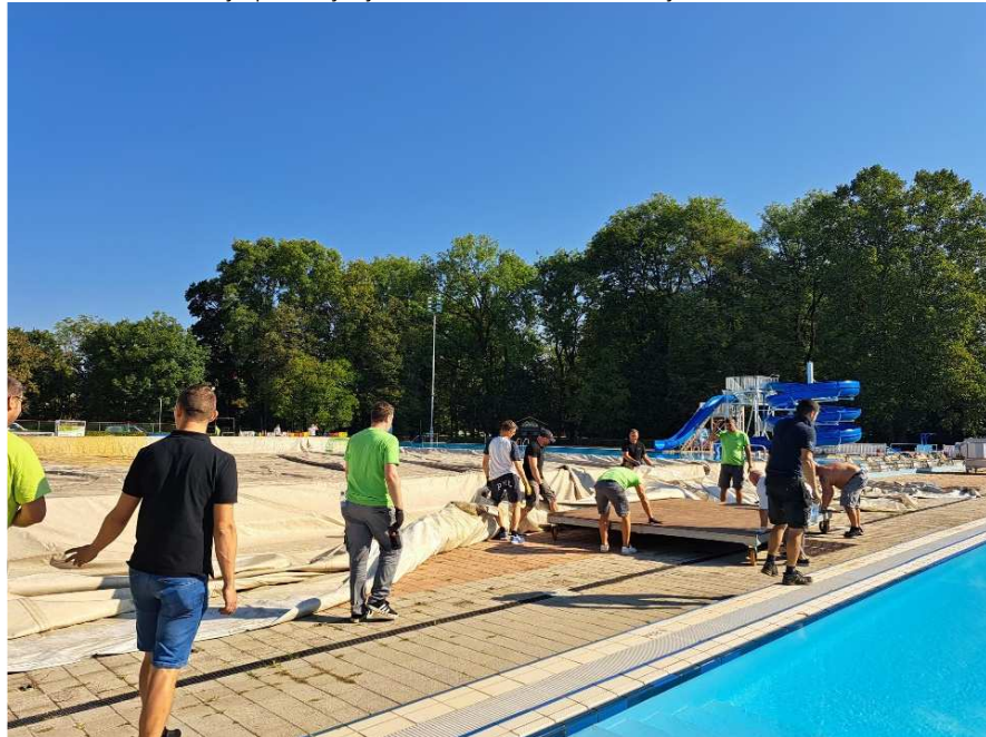
Slika 28: Podiranje/postavljanje balona na bazenu Kodeljevo
